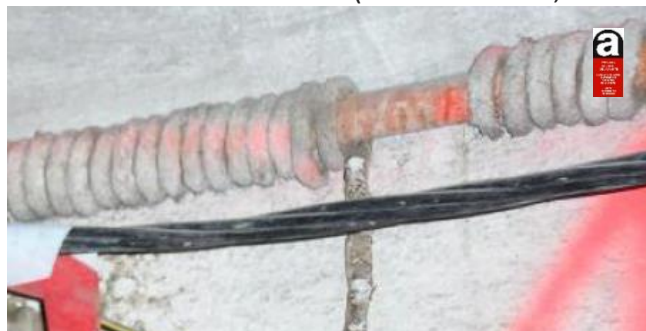
Intervention sur calorifugeages amiantés (en haut carton, en bas tresse)
