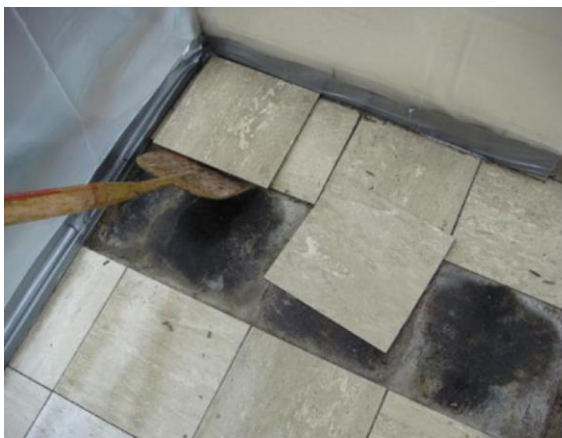
Remplacement d'une ou 2 Dalles de vinyle amiantées
