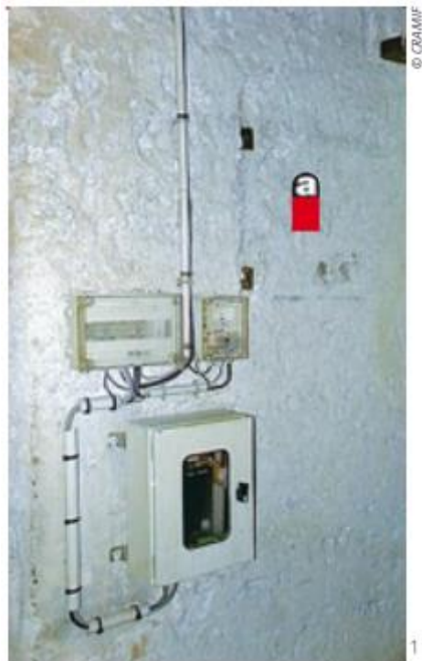
Intervention sur ou à proximité d'un boîtier électrique fixé sur une cloison recouverte d'un enduit amiante, (idem si bloc d'éclairage posé sur un flocage)
