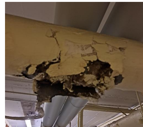
Rafistolage d'un calorifugeage
