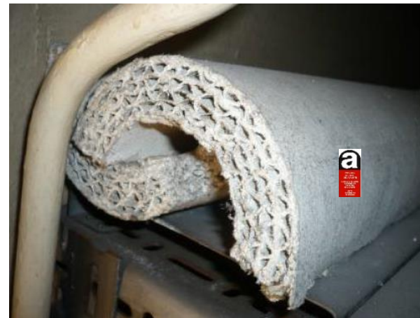
Intervention sur calorifugeages amiantés (en haut carton, en bas tresse)
