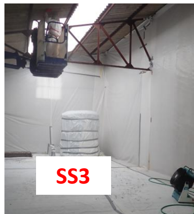
2/ Retrait d'une couverture en amiante ciment
