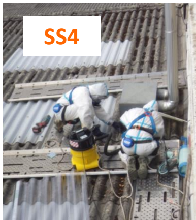
1/ Mise en place de puits de lumière
