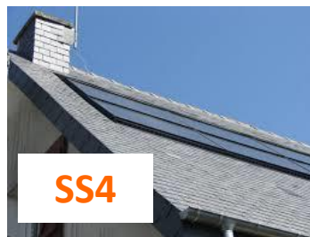
4/ Installation de 8 m2 de panneaux solaires nécessitant l'enlèvement des fausses ardoises amiantés
