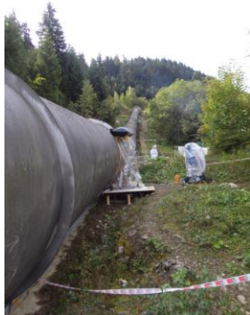
4/ Rénovation complète de la couche de protection anticorrosion amiantée d'une conduite forcée
