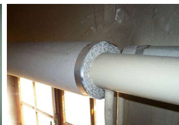
Calorifugeage
