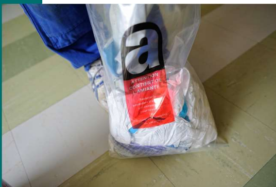
Sac pour EPI amiantés
