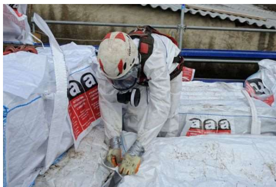
Dépôt bag amiante
