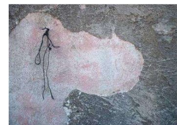
Crépi et enduit 20
